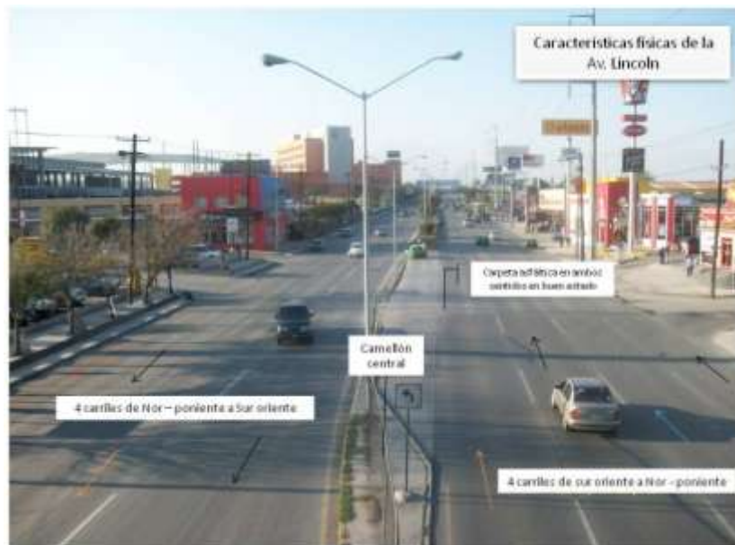
Figura 9. Situación actual de la avenida Lincoln.
