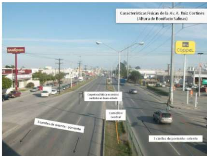
Figura 10. Situación actual de la avenida Adolfo Ruiz Cortines.
