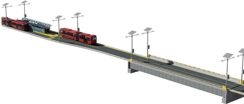
*Viaducto AV. 18 de Noviembre:* Paso Superior Vehicular (PSV), elemento perpendicular al eje del corredor que permite un libre flujo del corredor y por ende al FFCC, en este punto se tiene un TPDA de 44 mil vehículos; la estructura tiene un ancho total de calzada de 22.34 m. incluye banquetas y guarniciones, tres carriles por sentido, con una longitud (Claro) de 195 m.
