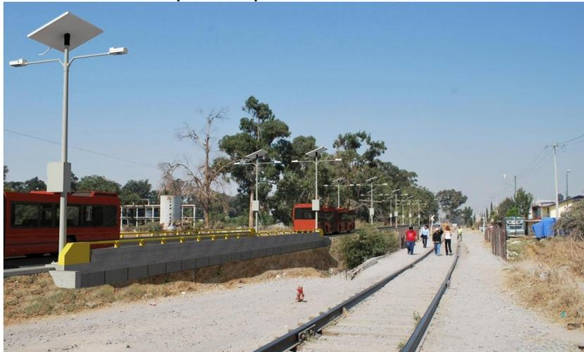
*Viaducto Cruce Vía de FFCC*: Paso Inferior Vehicular (PIV) elemento que se considera para realizar el cruce de la margen izquierda de la vía de FFCC. a la margen derecha de la misma, para el acceso a terminal Chachapa, cuenta con un ancho total de calzada de 7.40 m. incluye banquetas y guarniciones, un carril por sentido, con una longitud (claro) de 311 m.
