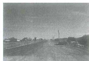
Km 26+500. Vista hacia Ciudad A. Base hidráulica impregnada lista para recibir capa absorbente de tensión (CAT).
