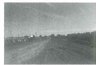
Km 25+600. Vista hacia Ciudad A. Trabajos de despalme previo a construcción de escalón de liga para ampliación de cuerpo.
