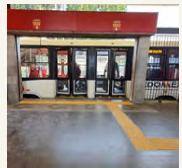
Guía de pavimento táctil colocada
